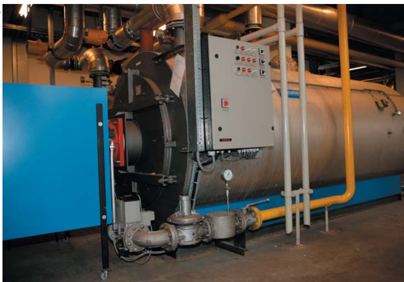
Ketels in een warmtekrachtcentrale van Nuon.
